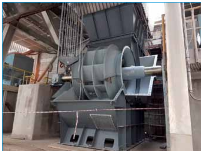
Rys. 2 Fotografia z fazy montażowej wentylatora promieniowego dwustronnie ssącego o mocy 2,6 MW
