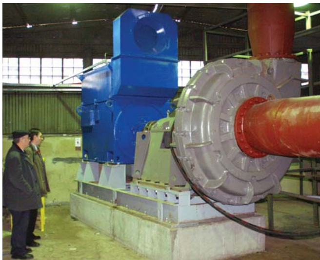
Fot. 1 Wielkość regulowanego zestawu pompowego od 4600 do 7260 V, co czyni napęd niewrażliwym na zakłócenia zasilania.
